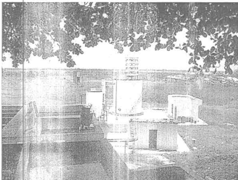
Fotografía No. 1 PTAR, a la distancia Ciénega Mesolandia.
